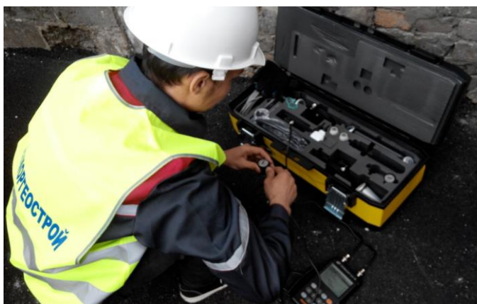
Рис. 2. Подготовка к проведению неразрушающего контроля
