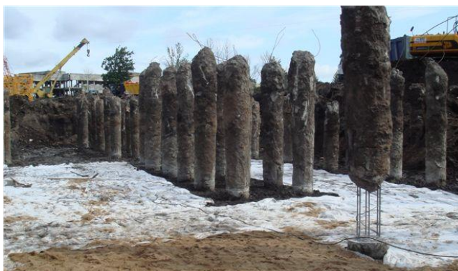
Рис. 3. Методика контроля позволяет выявлять нарушения технологии выполнения работ
