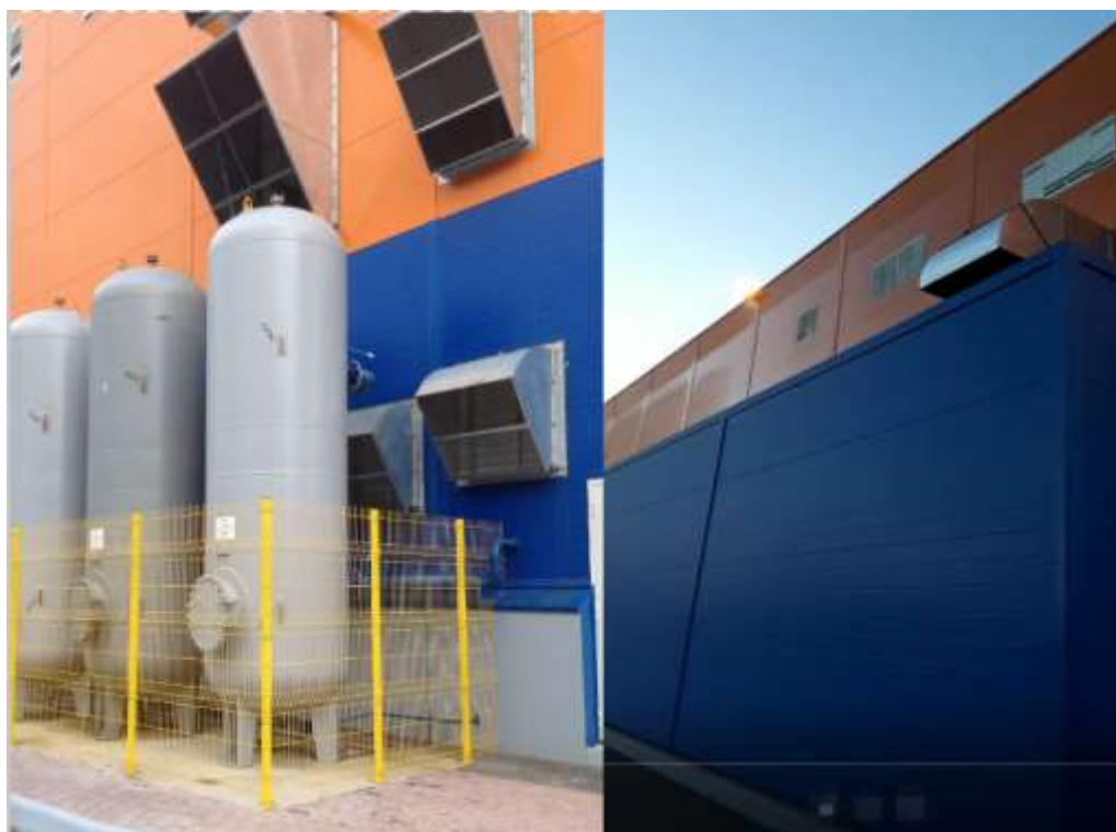
Рис. 4. Вид на территорию без установленного и с установленным технологическим шумозащитным экраном
