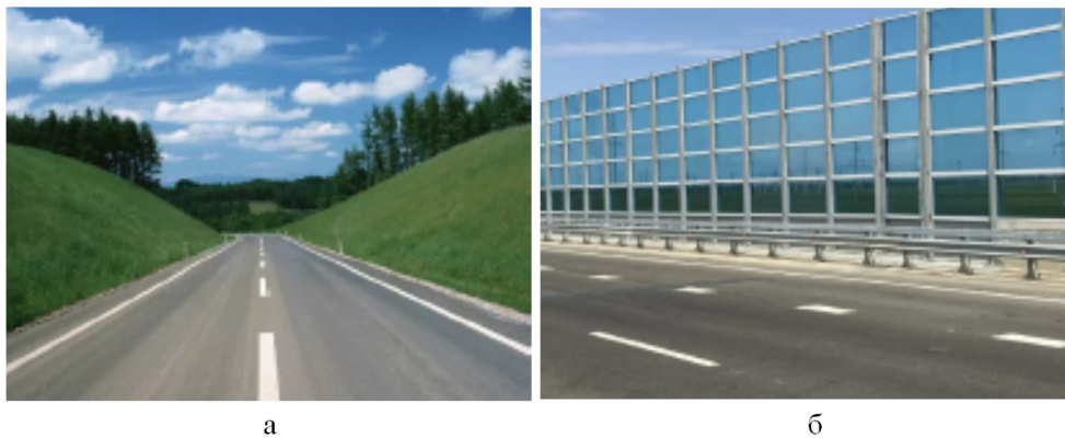
Рис. 4. Варианты исполнения шумозащитных мероприятий на пути распространения шума. а) Выемки, б) Шумозащитный экран
