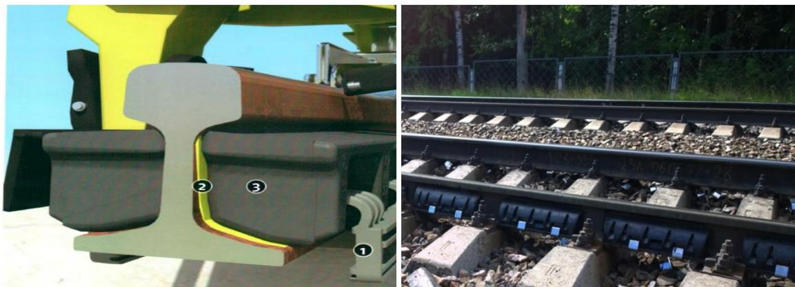
а) 1 – клемма из стекловолоконного композита; 2 – грунтровка; 3 – шумопоглощающий профиль из вулканизированной смеси резины; б) Пример использования вибродемпфирующих накладок на шейку рельса
