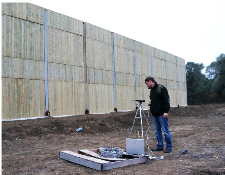
Рис. 5. Общий вид деревянного ШЭ
